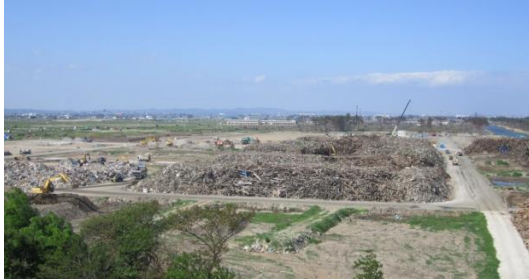
▲ 井土搬入場全景
